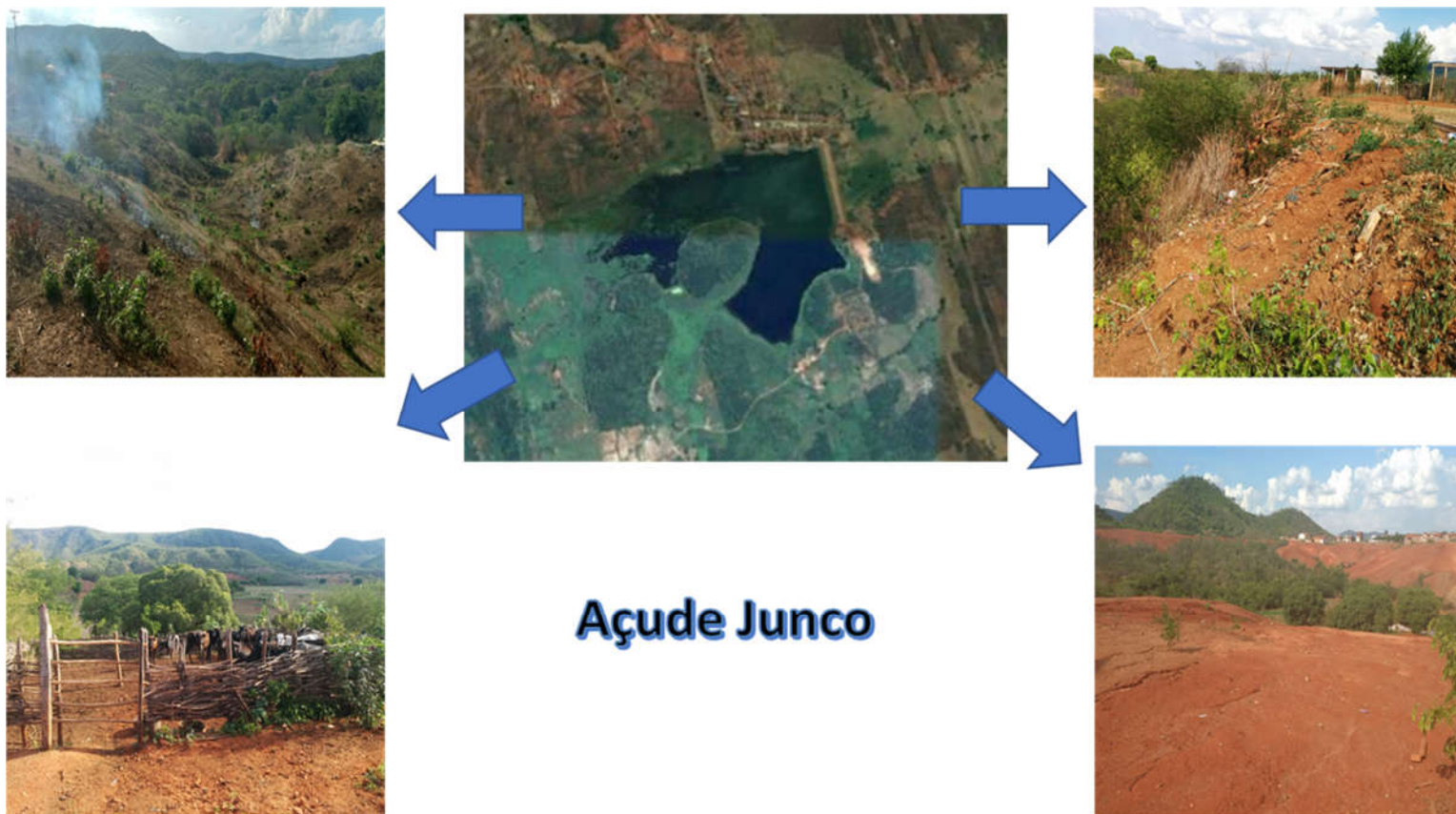
Figura 21 - Açude Junco: Campanha de campo realizada em 16/01/2017 - APP
